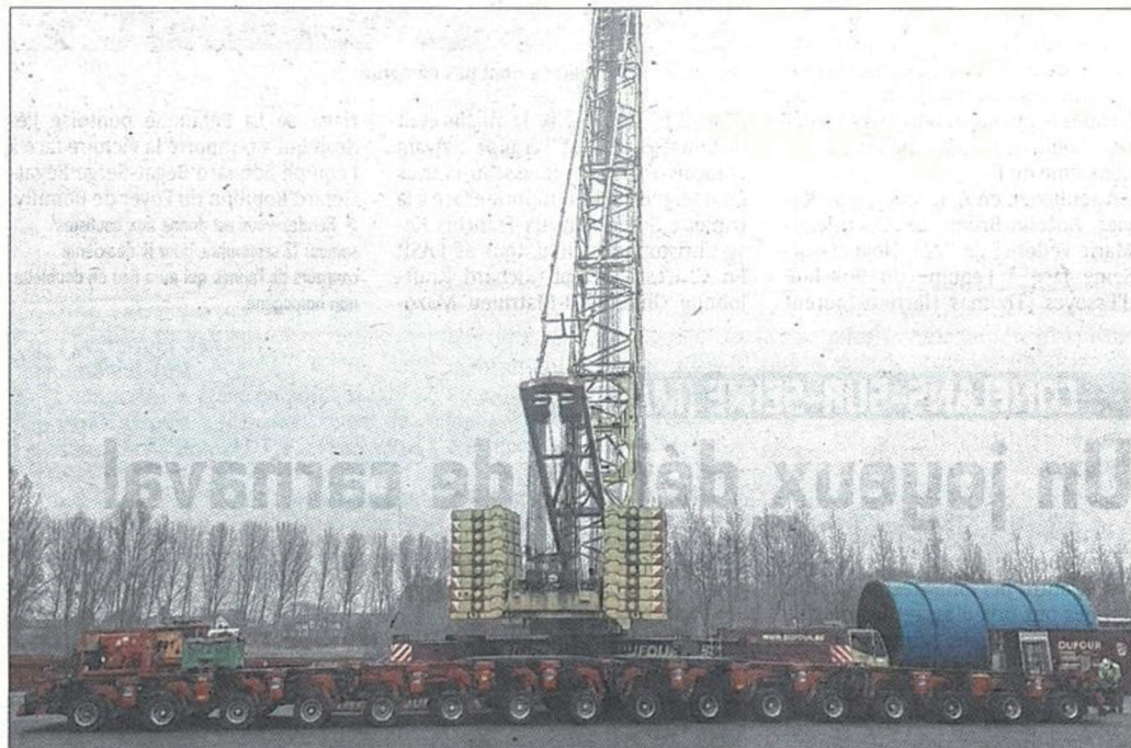
C'est sur cette remorque composée de 192 roues que le pôle de transformateur a été chargé au moyen d'une grue.
